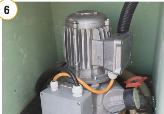
6 Une **petite centrale électrique** actionnée par l'eau du ruisseau fournit le courant à l'alpage de Curtginatsch. Aux heures de pointe où il faut beaucoup de courant, la turbine hydraulique ne suffit pas et il faut utiliser en plus un générateur diesel.
