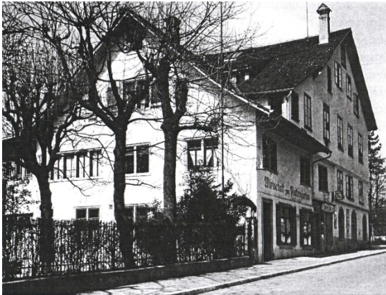
Q13 Zürich, Wirtschaft zum Plattengarten, kurz vor dem Abbruch 1956
