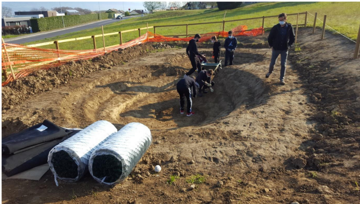
Création des profils de l'étang, une fois la creuse effectuée par la pelleteuse.
