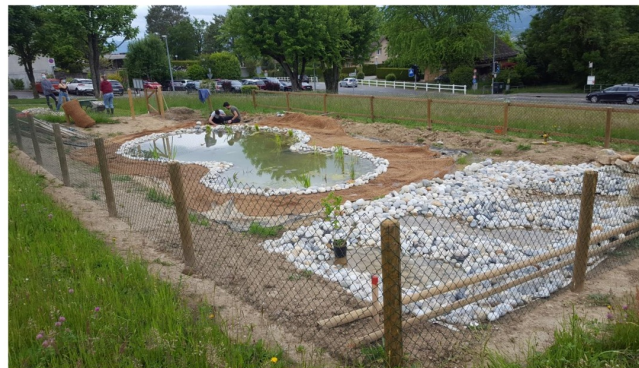
Pose de la fibre de coco (soutien des berges) et milieux aquatiques pionniers au 1 er plan.
