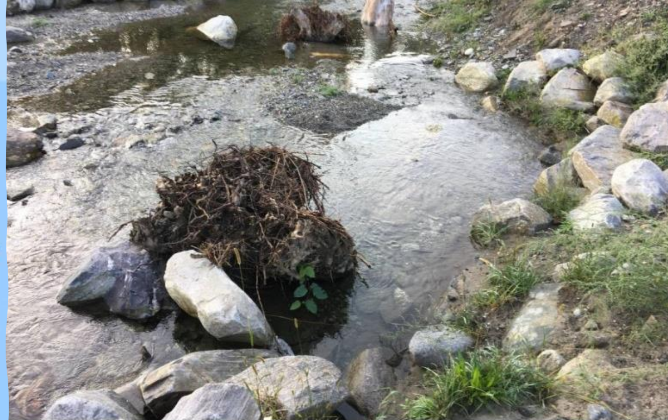
Diversificazione degli habitat in alveo mediante posa di blocchi, pietrame e ceppaie
